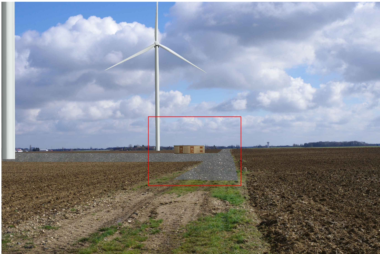
Point de vue sur le poste de livraison au pied de l'éolienne E04
