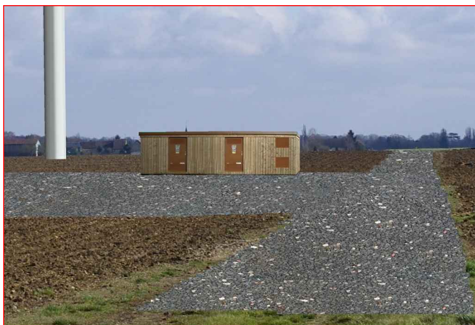
Zoom sur le poste de livraison
